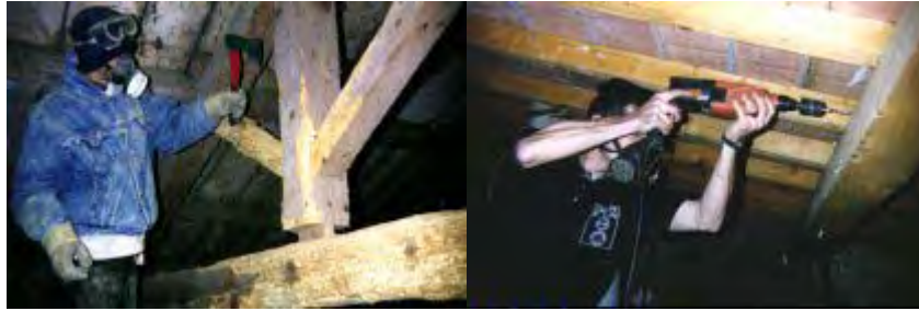
photo 12: Bûchage et perçage. (43)
