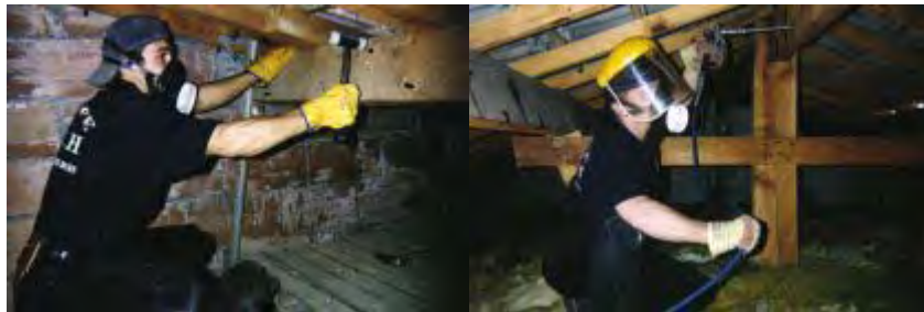
photo 13: Installation des injecteurs et injection de l'insecticide. (2)
