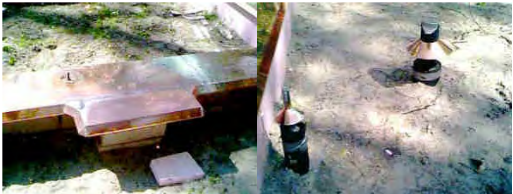
photo 14: Boucliers en cuivre mis en œuvre dans une maison canadienne. (98)
