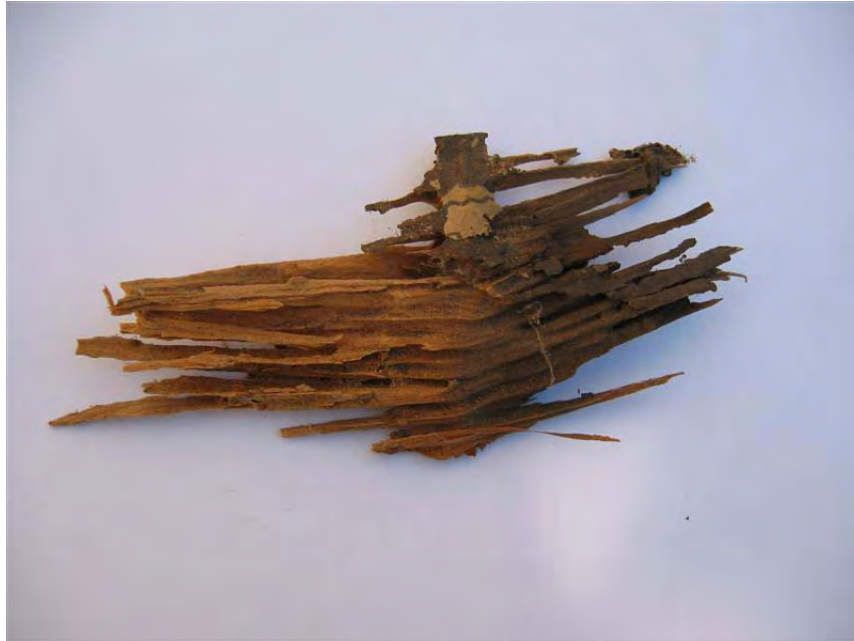
photo 10 : Aspect feuilleté caractéristique d'un morceau de bois attaqué par des termites souterrains (19).
