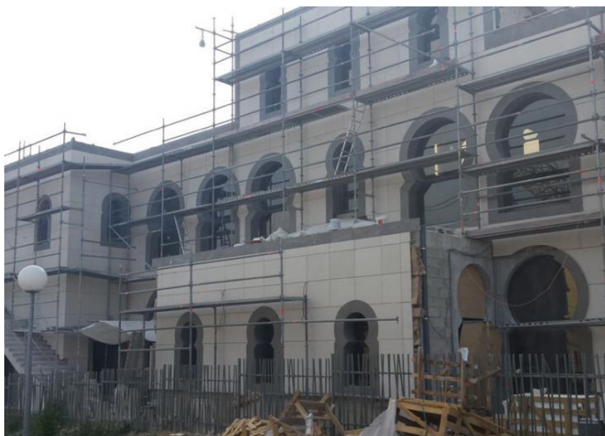
Photographie 3 : Mosquée de Chevilly-Larue en construction depuis 2013 (11)
