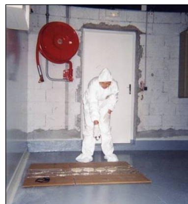
Figure 18 : Réalisation du Traitement curatif sur les stades juvéniles
