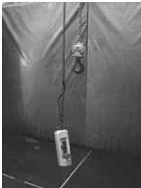
Photo 54 : Le palan de transport
