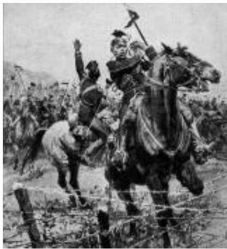
69- Charge de la cavalerie prussienne au cours de la guerre de 1870. (158)
