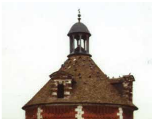
Figure 21 : Toiture du colombier de Bourgtheroulde
