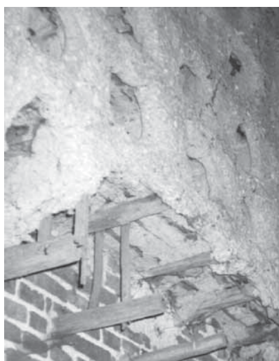
Figure 6 : armature des boulins de terre
