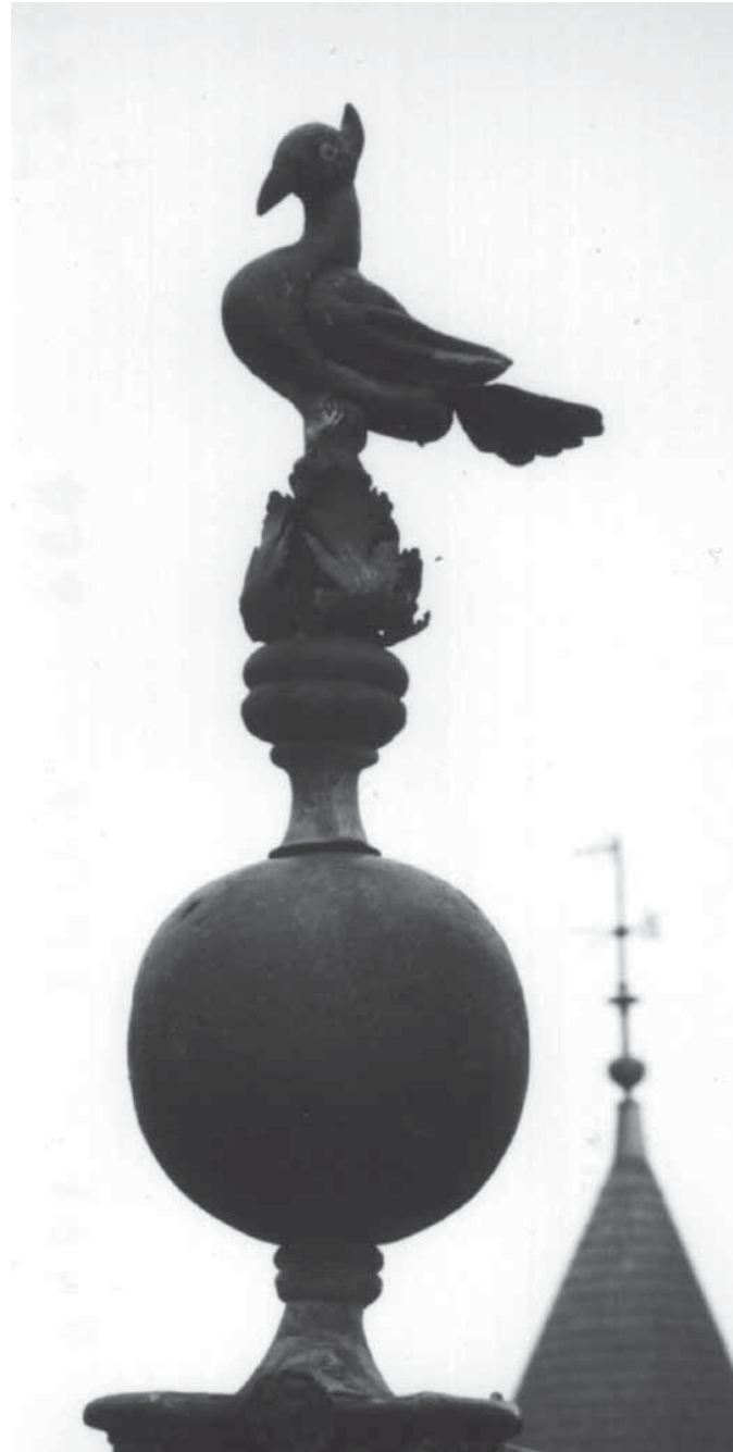
Figure 7 : épi de faîtage en plomb
