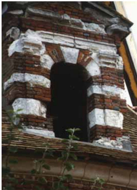
Figure 16 : Une des deux lucarnes du colombier de Bourgtheroulde
