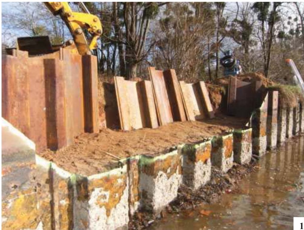
Figure 26 : Aménagement anti-noyade du canal latéral à la Loire [Hubert MORLAT©]
