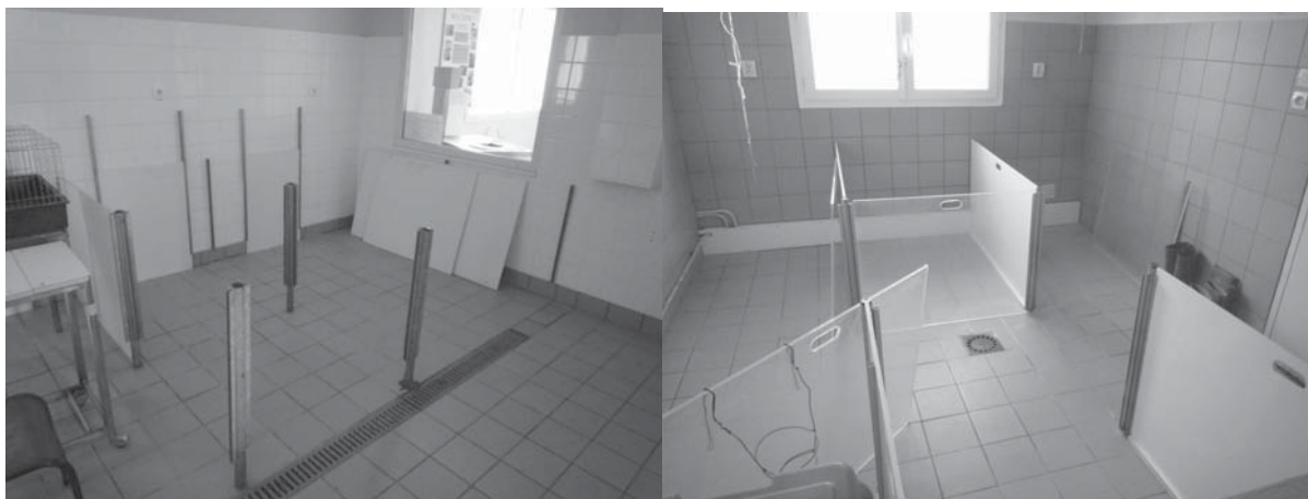
Photos 4 et 5 : Box au CHENE, à gauche grilles en inox normalement posées au sol, parois en plastique placées entre chaque compartiment, à droite box utilisés pour les phoques en temps normal et pour les oiseaux en cas de grosse affluence
