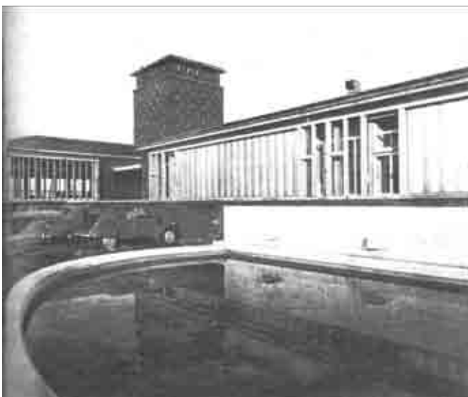
Photo 63 : Vue Ouest de la bibliothèque et la tour réserve des livres [59]
