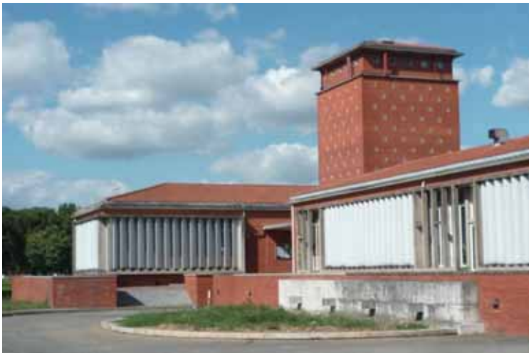
Photo 67 : Vue Ouest de la bibliothèque et la tour réserve des livres en 2010
