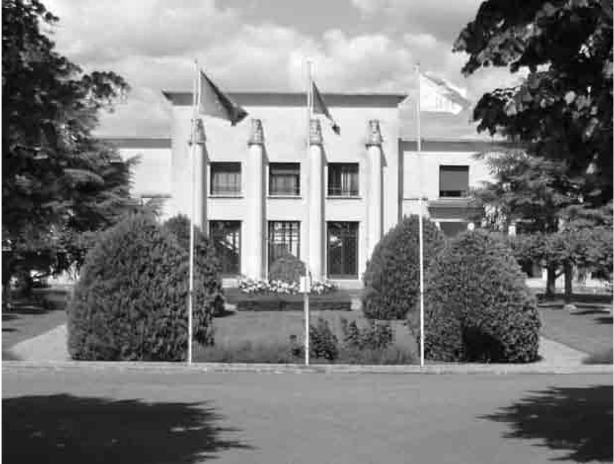
Photo 3 : Façade de l'ENSICA en 2010
