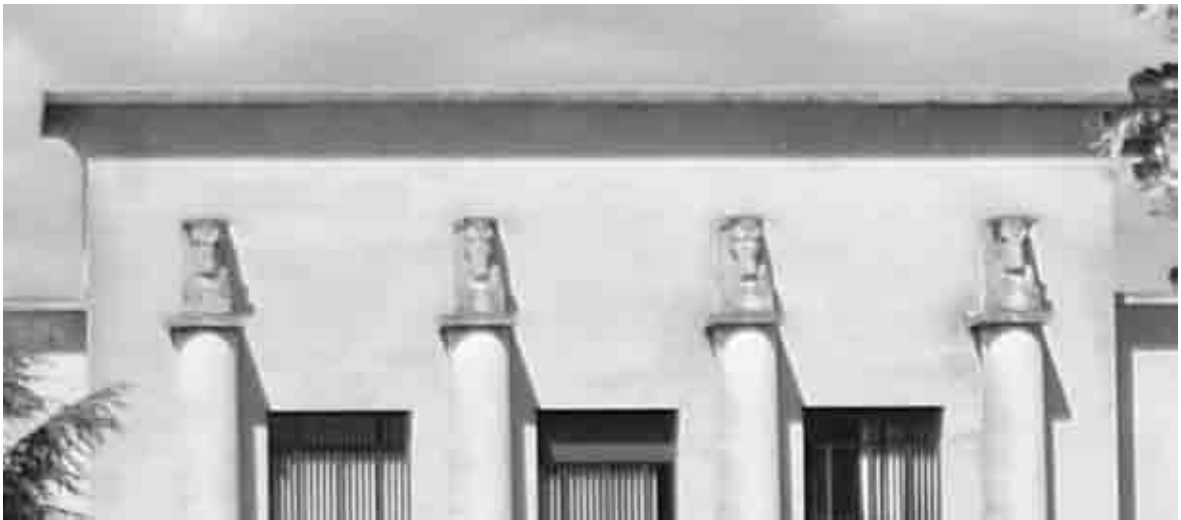
Photo 4 : Détail de la façade de l'ENSICA en 2010
