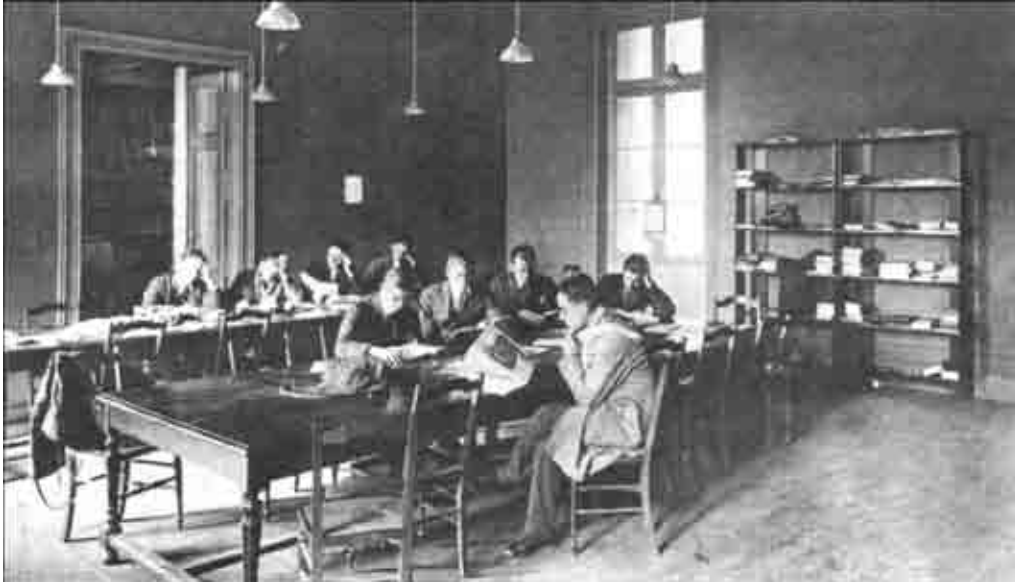
Photo 32 : Salle de lecture en 1929 (Véto Matabiau) [16]
