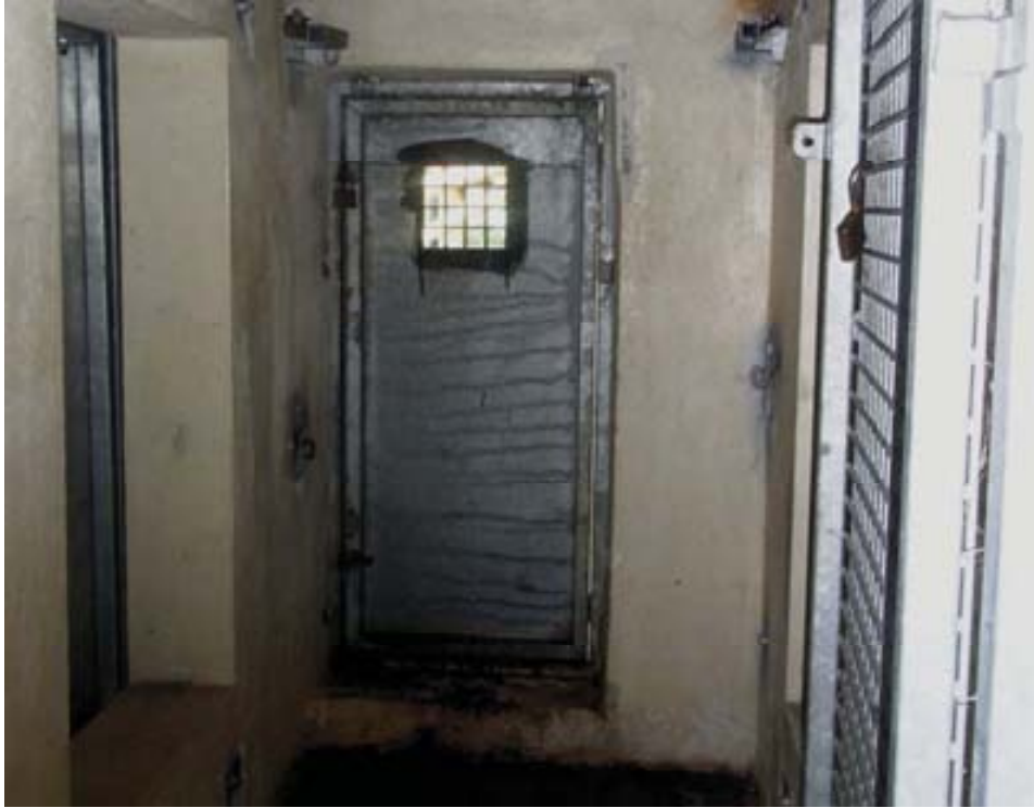
Photo 32 : Porte en acier galvanisé avec fenêtre grillagée, permettant l'accès à la zone d'habitat d'un groupe de chimpanzé. Remarquez la porte ouverte entièrement grillagée, au premier plan, servant de sas (ZooParc de Beauval) [Original]
