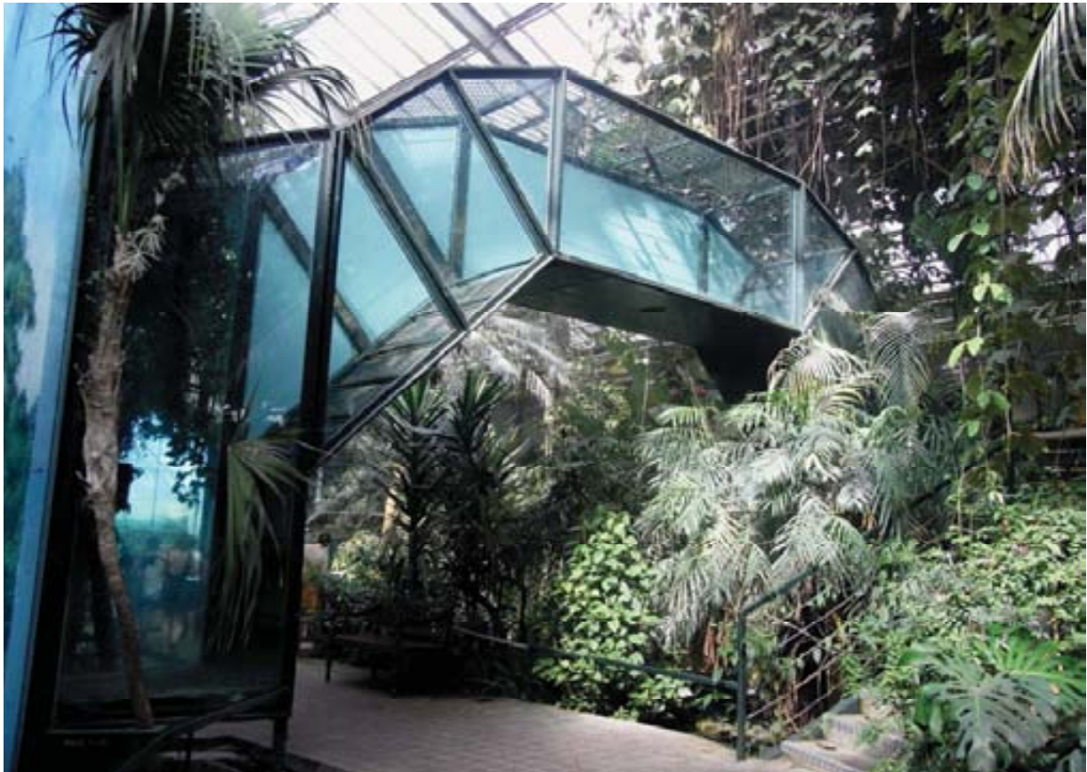
Photo 27 : Tunnel vitré passant au-dessus du public dans une serre tropicale (ZooParc de Beauval) [Original]
