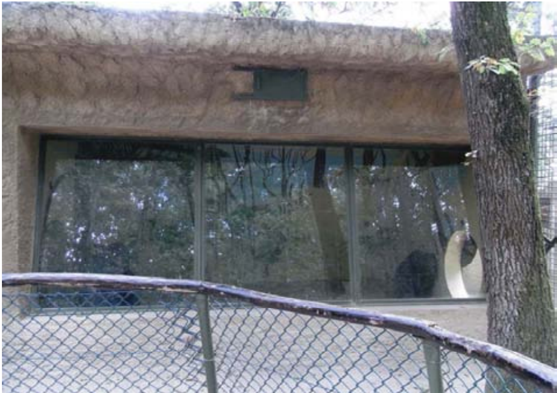
Photo 9 : Bâtiment de jour des chimpanzés du zoo AFRICAN SAFARI [original]
