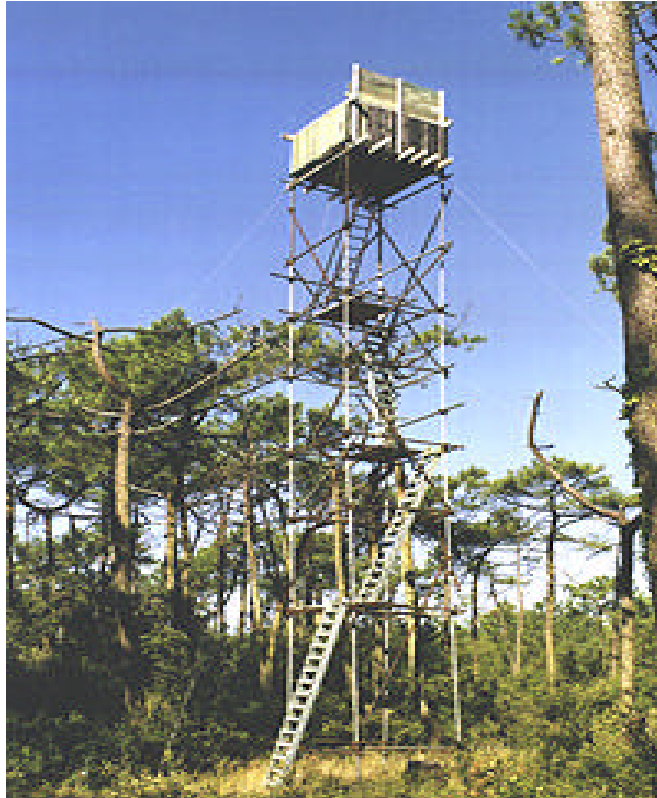
Figure 24 : Pylône de chasse en fer dans la futaie [Photo personnelle]
