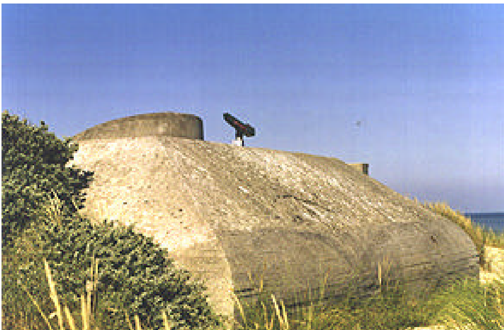
Figure 15 : Site d'observation des oiseaux migrateurs [photo personnelle]
