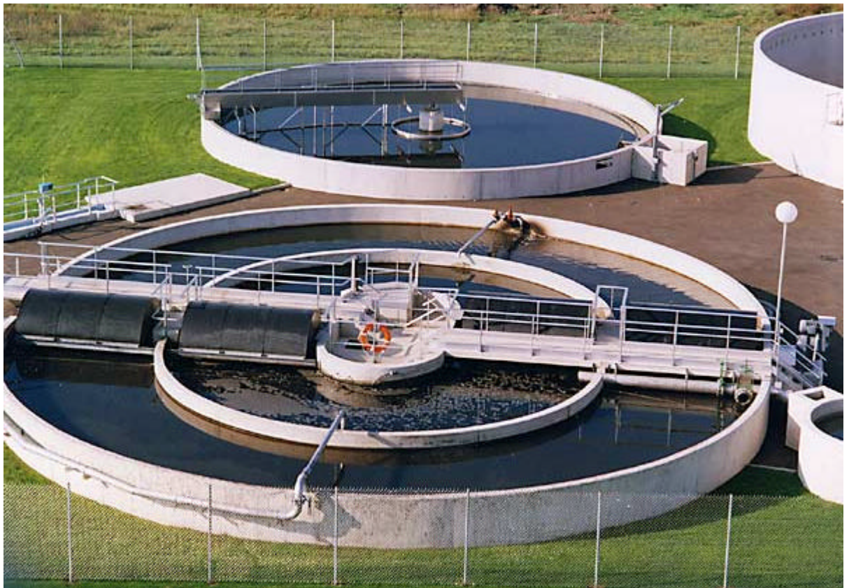
Figure 6 : Dégraisseur – dessableur aéré (Cliché Alpha)
