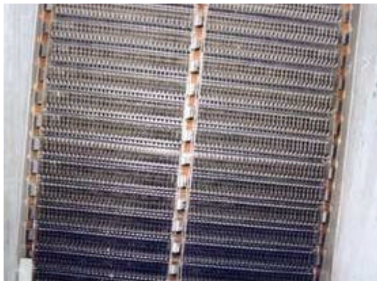
Figure 3 : Dégrielleur à grille droite à nettoyage continu (cliché Honet)
