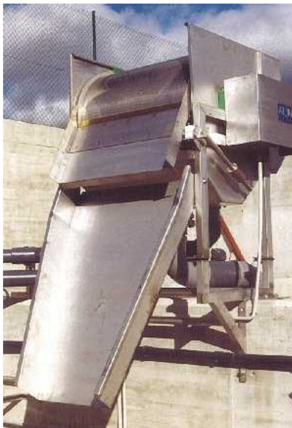
Figure 5 : Tamis rotatif à alimentation externe (cliché Aaqua Waste Waster Technology)
